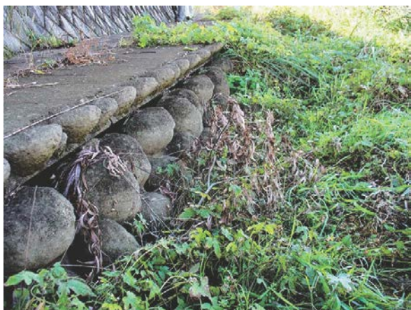
写真-2 魚巣ブロックが埋塞した例
