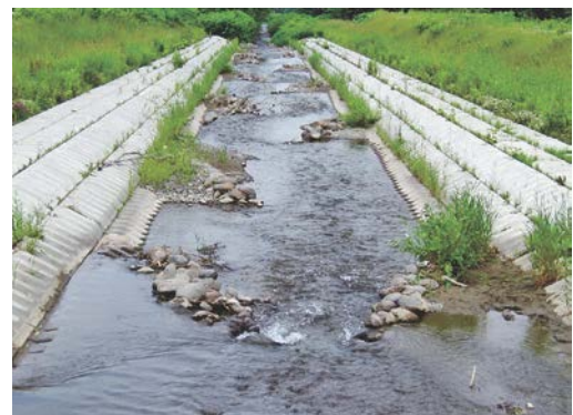
写真-5 両岸から突き出したバープ工 水際への堆積を促し、流心には瀬を創出している
