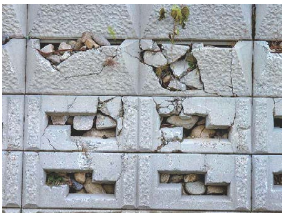
写真-1 転石で破損した護岸の例
