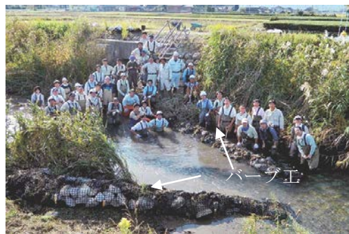
写真-8 完成したバープ工の前で記念撮影 両岸から突き出ている構造物がバープ工（矢印の部分）を示す。
