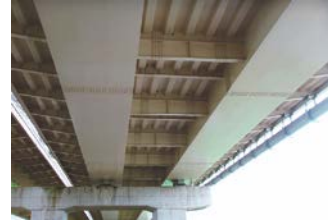
図-1 鋼床版を有する箱桁橋の全景
