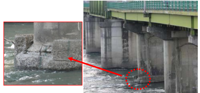
写真-2 ケーソン基礎頂版部の損傷に伴い下部構造が傾斜した事例(2011年東北地方太平洋沖地震)
