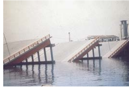
写真-1 パイルバント橋脚・基礎の落橋事例(昭和大橋・1964年新潟地震)
