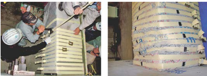
写真-2 CAESARで研究開発した機械式定着繊維バンドによるRC橋脚の応急復旧技術
