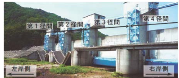
写真-5 普代水門管理橋
