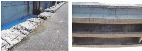
(a) 地覆部の圧壊 (b) 主桁に多数の曲げひび割れ 写真-6 第3径間の損傷状況
