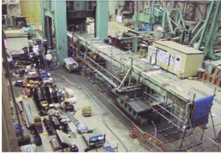
写真-4 撤去桁の荷重試験
