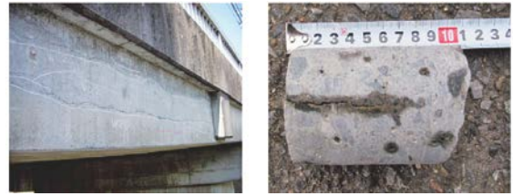
(a) 主桁側面 (b) コアのひび割れ状況 写真-3 軸方向ひび割れが生じたPC橋
