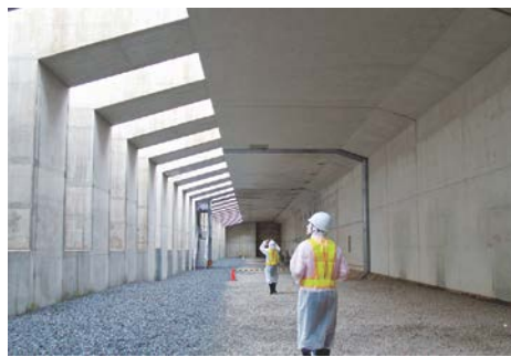
写真-11 試験施工で完成した地下高速道路
