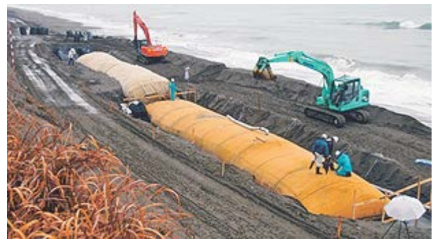
図-5 サンドバック設置状況(2012年3月、動物園東)
