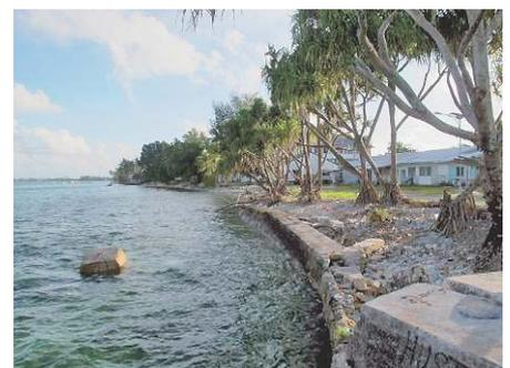
写真-6 突堤a東側の波の直接作用を受ける護岸
