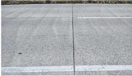
写真-2 健全な目地材の例 5)
