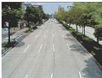
写真-1 コンクリート舗装
