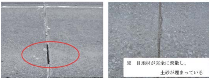
写真-4 目地材の飛散の例 5)
