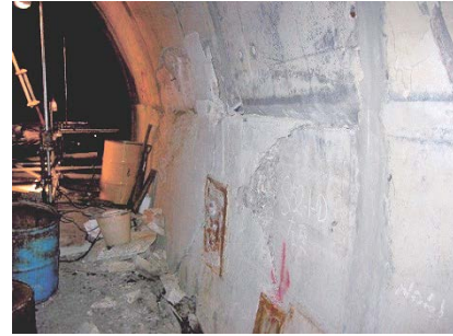
写真-1 側壁の変状状況の例
