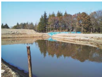
写真-1 簡易沈殿池 (素堀した池での応急対応例)
