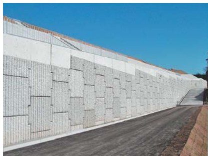
写真-1 テールアルメ工法
