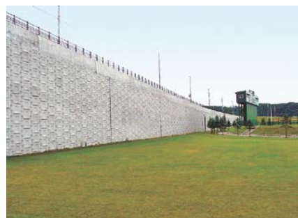
写真-2 多数アンカー工法
