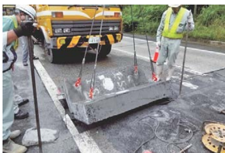
写真-1 損傷目地部（収縮目地）
