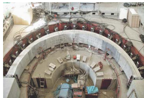
写真-1 実大規模の覆工載荷実験
