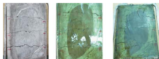
(a) 施工前 (b) 施工直後 (c) 施工5日後
