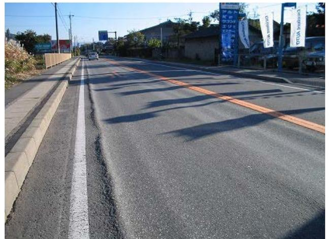
写真-2 路面の経年劣化 (わだち掘れ)
