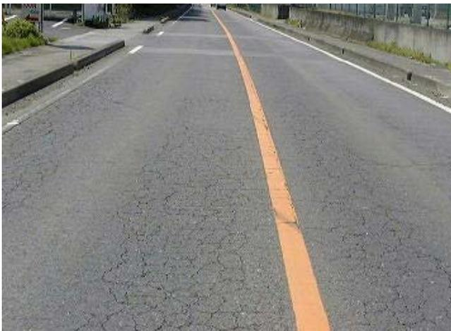
写真-1 路面の経年劣化 (ひび割れ)
