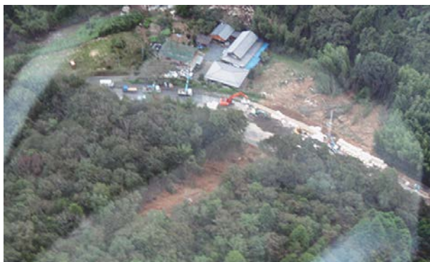
写真-1 斜面崩壊の発生状況（平成23年9月）
