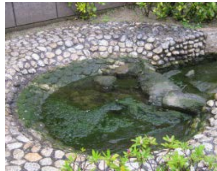
写真-2 糸状藻類の大量発生した水路
