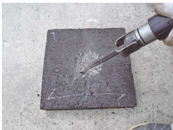
写真-3 電動ピックによる削孔
