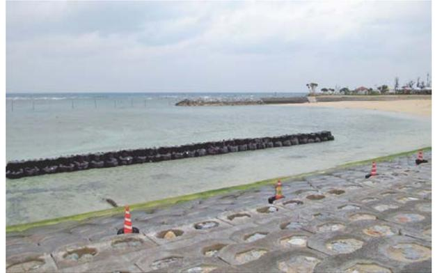
図-8 サンセットビーチ中央部の露出した緩傾斜護岸
