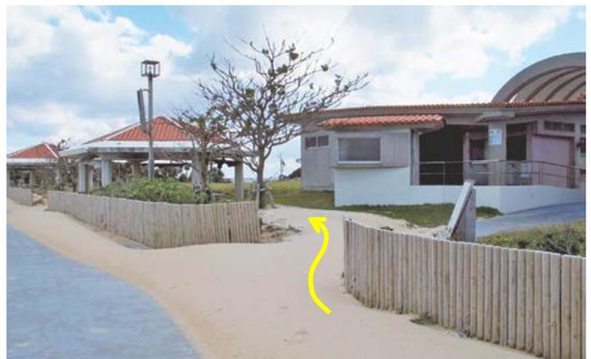
図-6 木杭列堆砂垣間の開口部から背後地への飛砂の侵入(あざまサンサンビーチ)
