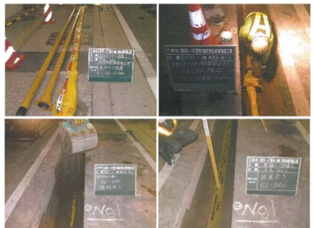
写真-2 再生水管布設状況
