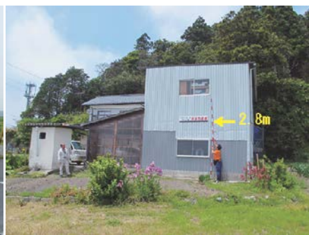
写真-2 津波到達線（地盤面上2.8m）
