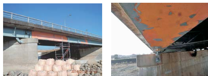
写真-3 塗膜のはく離の状況（A橋）
