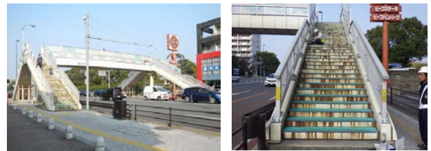
写真-1 全体と蹴上げ部の損傷事例（同じ橋）
