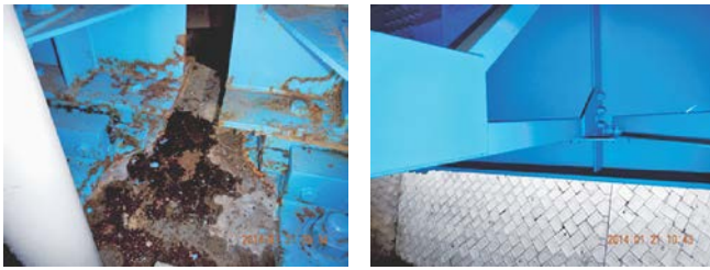
写真-4 桁端部の腐食、塗膜劣化（左）と中間部の状況（右、健全）（B橋）
