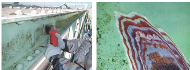
写真-2 塗膜の切削状況と切削後の塗膜構成 検知管法で補完した。
