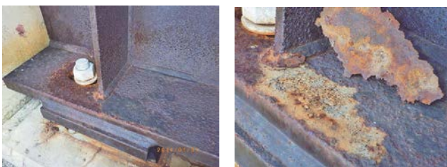
写真-5 桁端部の損傷状況（C橋）
