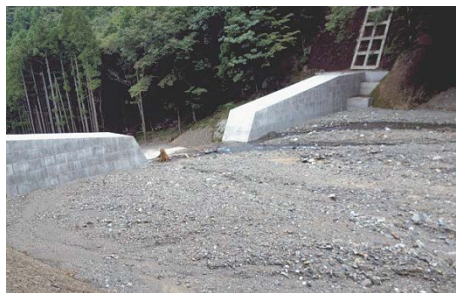
写真-3 八幡川2号堰堤の土砂捕捉状況
