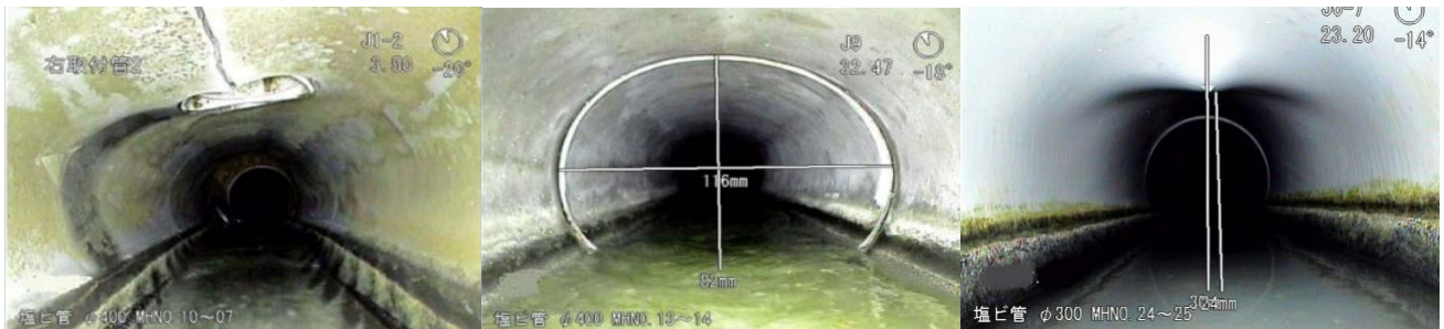
写真-1 破損の事例
