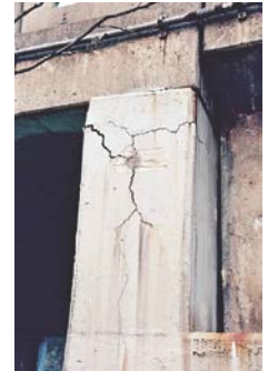
写真-1 橋脚のASR損傷の例（オリエンタル白石、角本氏撮影）
