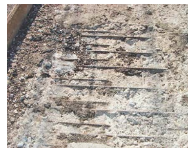
写真-2 床版上側主筋の露出状況
