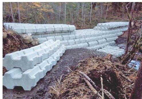
写真-3 御嶽山山麓の溪流に設置されたコンクリートブロック堰堤
