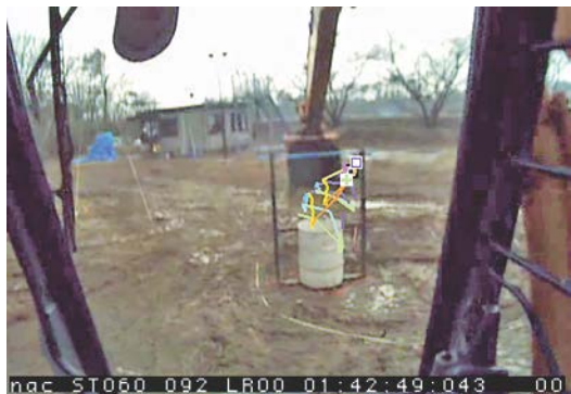
写真-5 オペレータ作業視点(経験1年未満)
