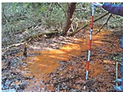
写真-2 盛土法尻部の湧水例
