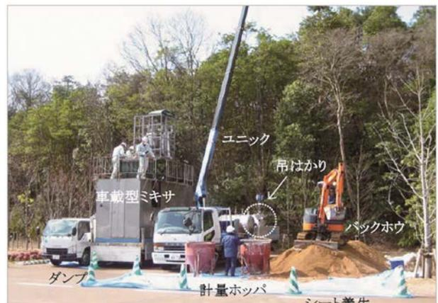
写真-1 大規模工事の製造機械と機械配置例
