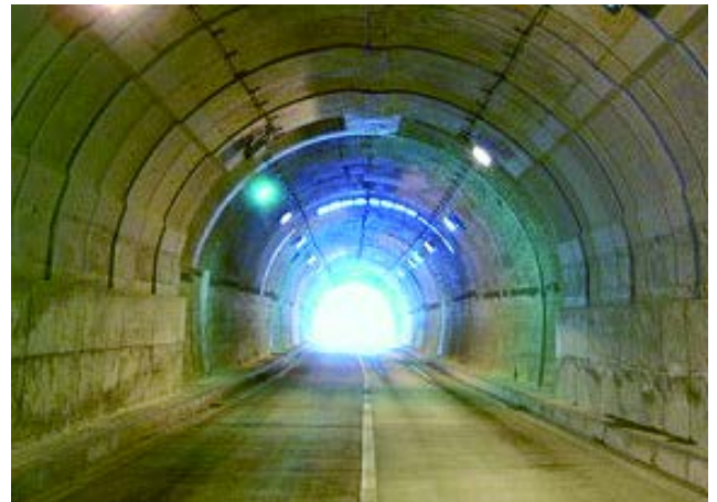
写真-8 部分薄肉化PCL工法工事完了
