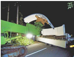
写真-2 PCL版荷取り
