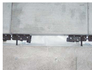
写真-7 連結金具固定
