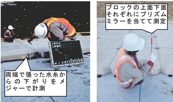
写真-1 従来手法(左)とTS(右)測定の様子
