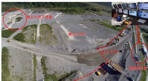
写真-1 無人化施工エリア（2013.9雲仙復興現場より）
