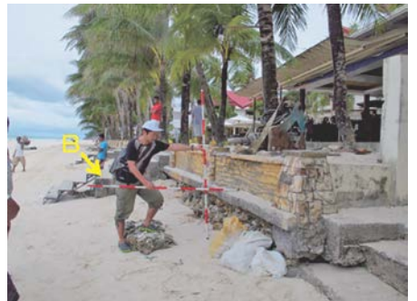
写真-9 レストラン付近での侵食
