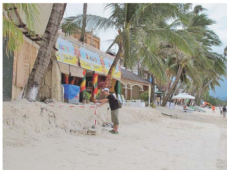
写真-11 南側隣接部での侵食
