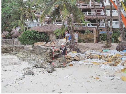
写真-2 護岸の崩壊と多数の土嚢
