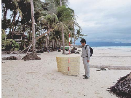
写真-5 露出したマンホール (St.3)
