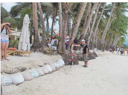
写真-13 設置された土嚢 (St.6)
