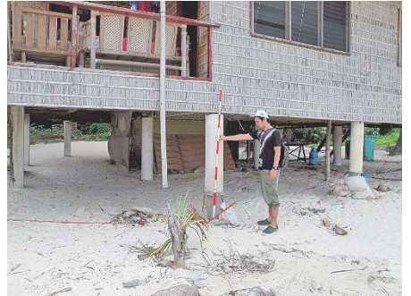
写真-6 住居の杭基礎の露出
