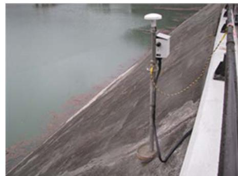
写真-1 法面部におけるGPSセンサーの設置状況 (コンクリート遮水壁上の設置)
