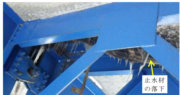
写真-2 伸縮装置からの漏水状況 (写真-1の矢印箇所、後付けの止水材が部分的に外れて、垂れ下がっていた。後述のC橋)
