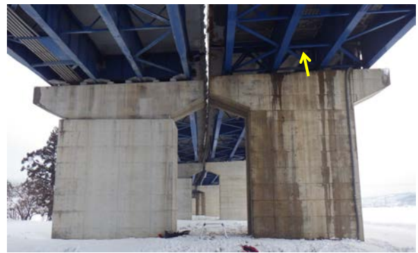
写真-1 多連続桁橋の桁端部からの漏水事例 (奥に見える中間支点下の橋脚に比べて、橋脚の外観が漏水の有無により顕著に異なる。後述のC橋の外観)
