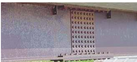
写真-1 主桁の継手部
