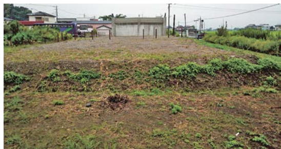
写真-4 地盤改良実施前
