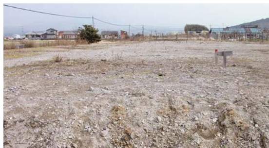
写真-7 地盤改良完了後
