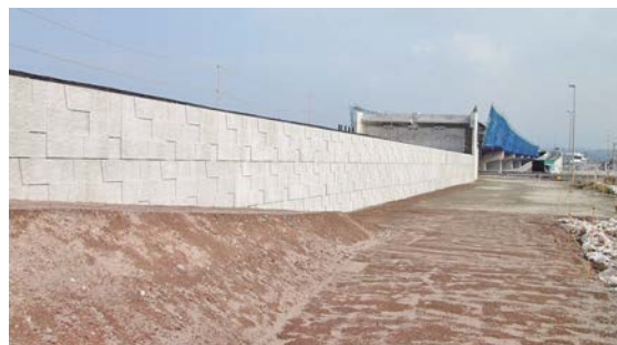
写真-8 盛土構築状況(見学会とは別地点)
