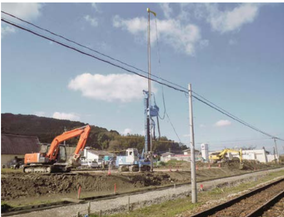
写真-2 深層混合処理の施工状況
