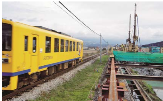
写真-5 現場施工状況（鉄道近接）
