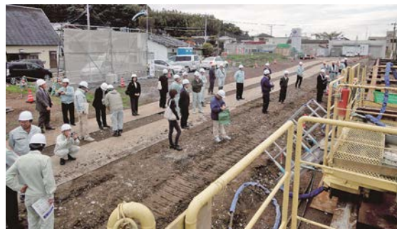
写真-6 現場見学会状況
