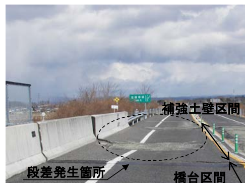
写真-1 橋台背面の段差
