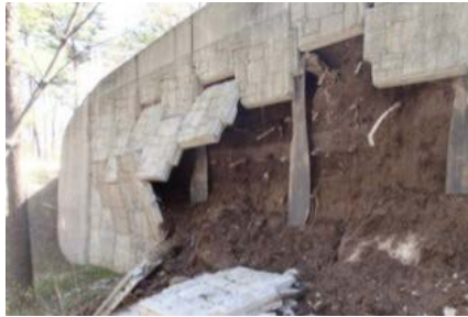
写真-2 壁面材の脱落事例
