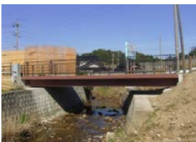
写真-3 自転車道13号橋
