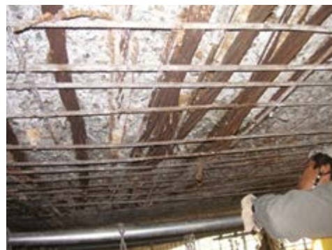
図-1 PC鋼材の腐食・破断
