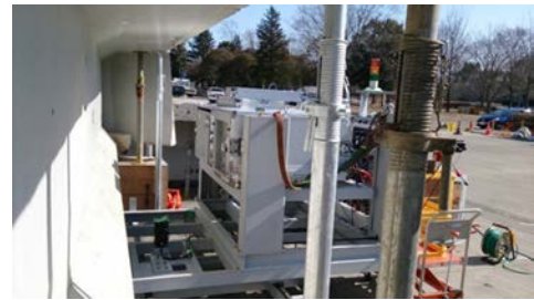
図-4 撤去桁の撮影状況
