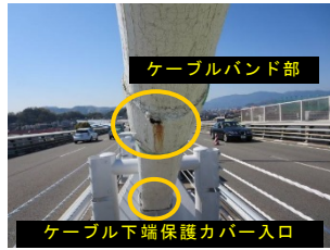
写真-6 詳細調査箇所
