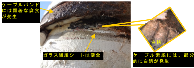
写真-7 ケーブルバンド部の内部状況
