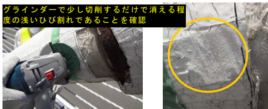
写真-8 表面被覆材表面のひび割れ状況
