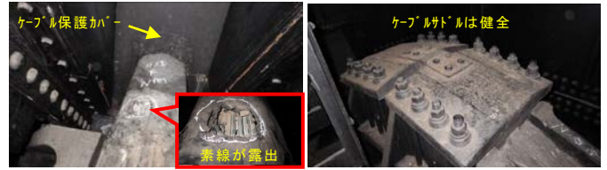
写真-3 塔内ケーブル定着部の現況写真
