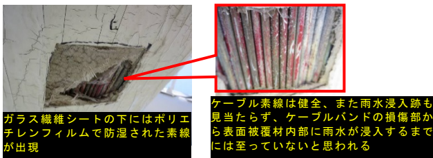
写真-9 ケーブル下端保護カバー入口の素線状況
