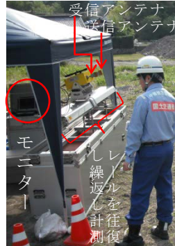
図-1 地上型SARの設置状況と設置上の留意点
