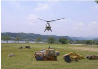
写真-15 分解型バックホウの空輸状況
