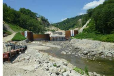
写真-16 湯浜砂防堰堤(鋼製セル)
