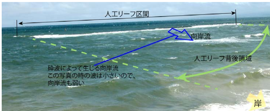
写真-2 人工リーフ上の砕波と背後の乱れた状態（皆生海岸富益工区）
