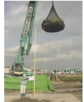
写真-4 落下・吊上げ性能試験
