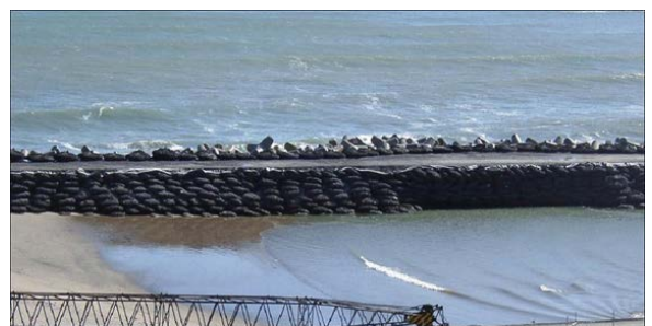
写真-6 適用事例（工事用仮設道路）
