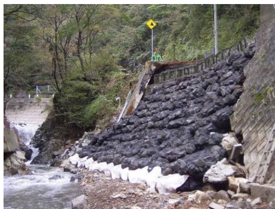
(b) のり面対策に適用した事例
