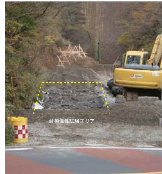
写真-3 耐損傷性試験
