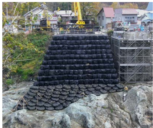
写真-7 耐候性大型土のうとの組合せ事例（工所用仮設構台）
