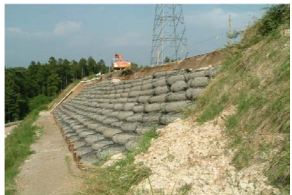
写真-5 適用事例（土留め構造物）
