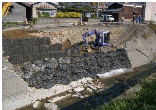
(a) 基礎地盤に適用した事例
