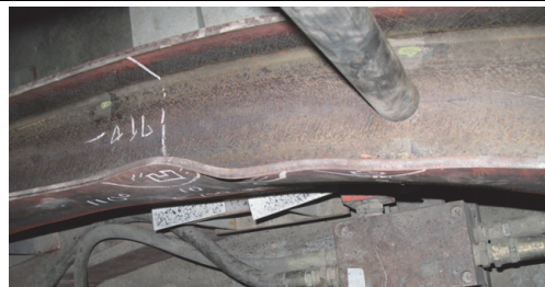
写真-2 部分座屈の発生状況（NH-150）
