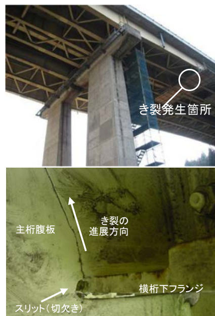
写真-1 鋼桁橋の主桁溶接部に発生したき裂
