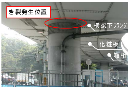
写真-3 疲労損傷が確認された鋼製橋脚隅角部の全景
