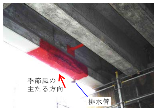
写真-4 季節風により排水が主桁にかかり腐食した事例 3)
