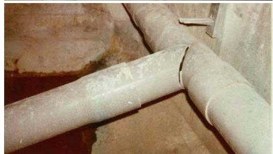
写真-1 箱桁内部の排水管と継手部の損傷例 2),3)
