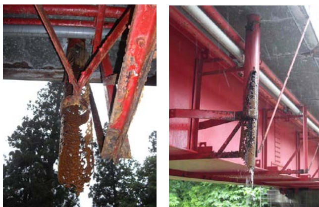
写真-3 鋼製排水管の腐食事例
