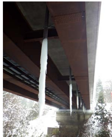
写真-7 流末水の凍結事例 (12月中旬、前夜に降雨なし、最低気温-4℃)
