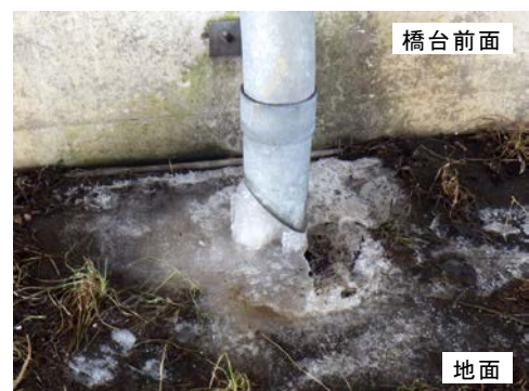
写真-8 橋台前面の流末水の凍結事例 (2月下旬、前夜に降雨なし、最低気温-1℃)
