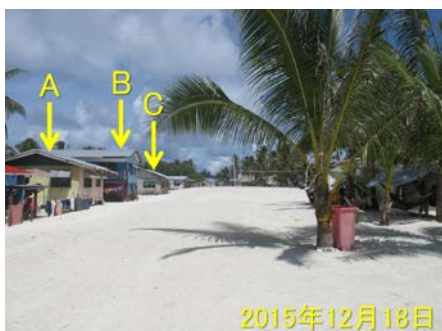
写真-5 東岸に沿った住宅地前面のトレンチを埋めてできた新地盤
