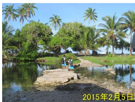
写真-3 満潮時における小道中央部
