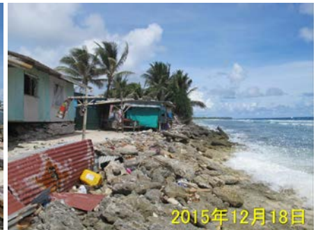
写真-15 外洋側の海岸状況を北向きに撮影
