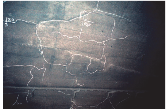
写真-2 不規則なひび割れの例
